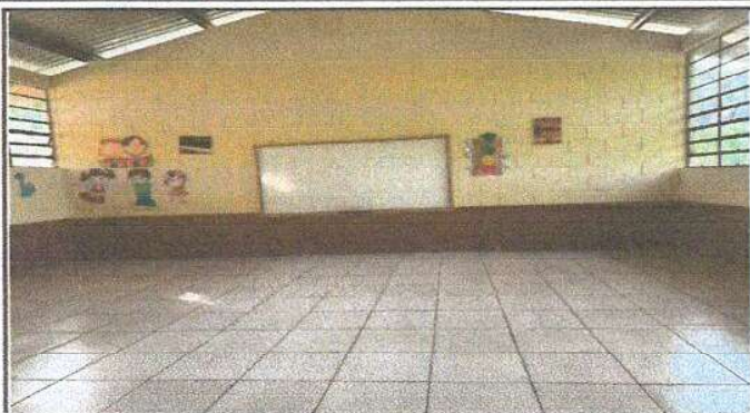
Foto1: se visualiza la instalación completa de piso cerámico en el aula. Módulo II
