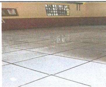
Foto 2: Se visualiza la instalación completa de piso cerámico, Módulo I
